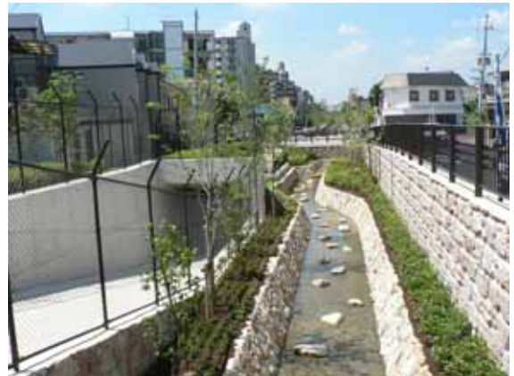
七瀬川。2層式の河川です。左がトンネル。
