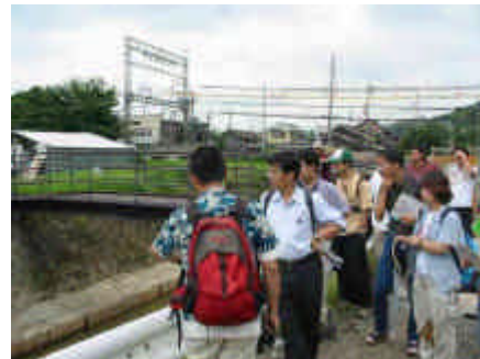
河川工事現場の解説
