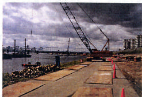
* クローラークレーン(50t)での設置状況
