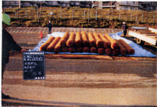
* 植生ロール材料確認(φ500・L=4m) 1本当りの重量は約350kg程度
