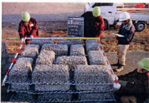
* ポーラスブロック材料確認(2m×2m) 1枚当りの重量は約880kg程度
