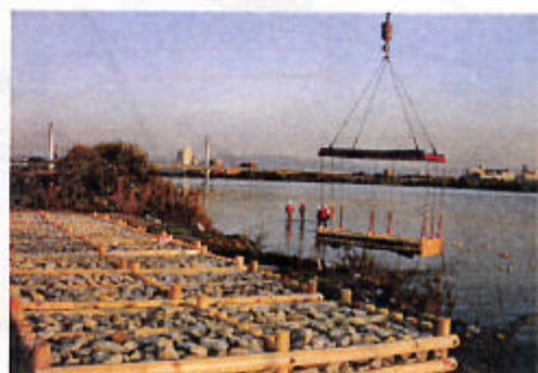
* 手前の木工沈床が栗石を詰め込んだ状態で 奥がクローラークレーン(100t)で設置している状況
