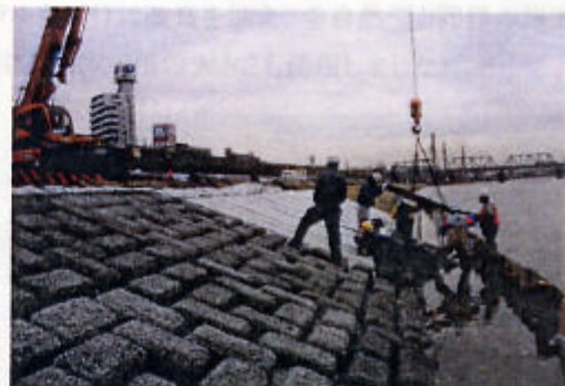
* クレーン(25t)での設置状況 ポーラスブロックの下には吸出し防止マットを設置
