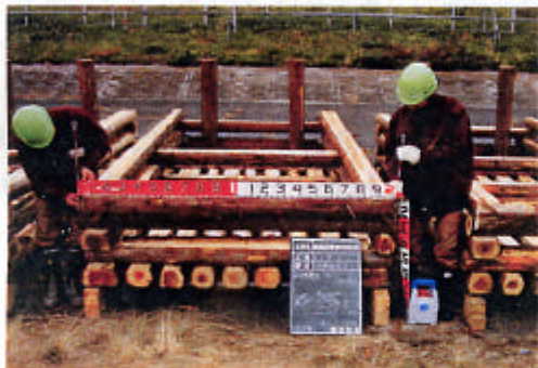
* 写真のサイズは2m×4m×0.5m(高)で奥にあるのは 植生ロールを固定する木杭
