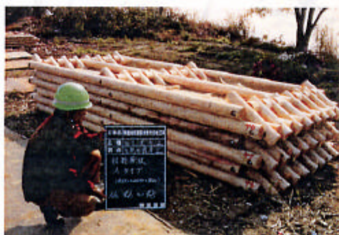
* 写真は折りたたんで搬入してきた状態 生態系は植生ロールが無いので木杭は無い。
