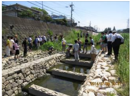
川勝水辺ひろば。大阪府による事業です。魚道ができています。2013(平成25)年6月開設。
