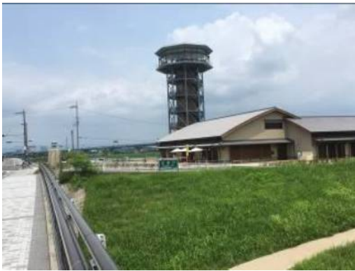
1 日目。会場のさくらであい館です。2017 年 3 月開館。高さ 27m。
